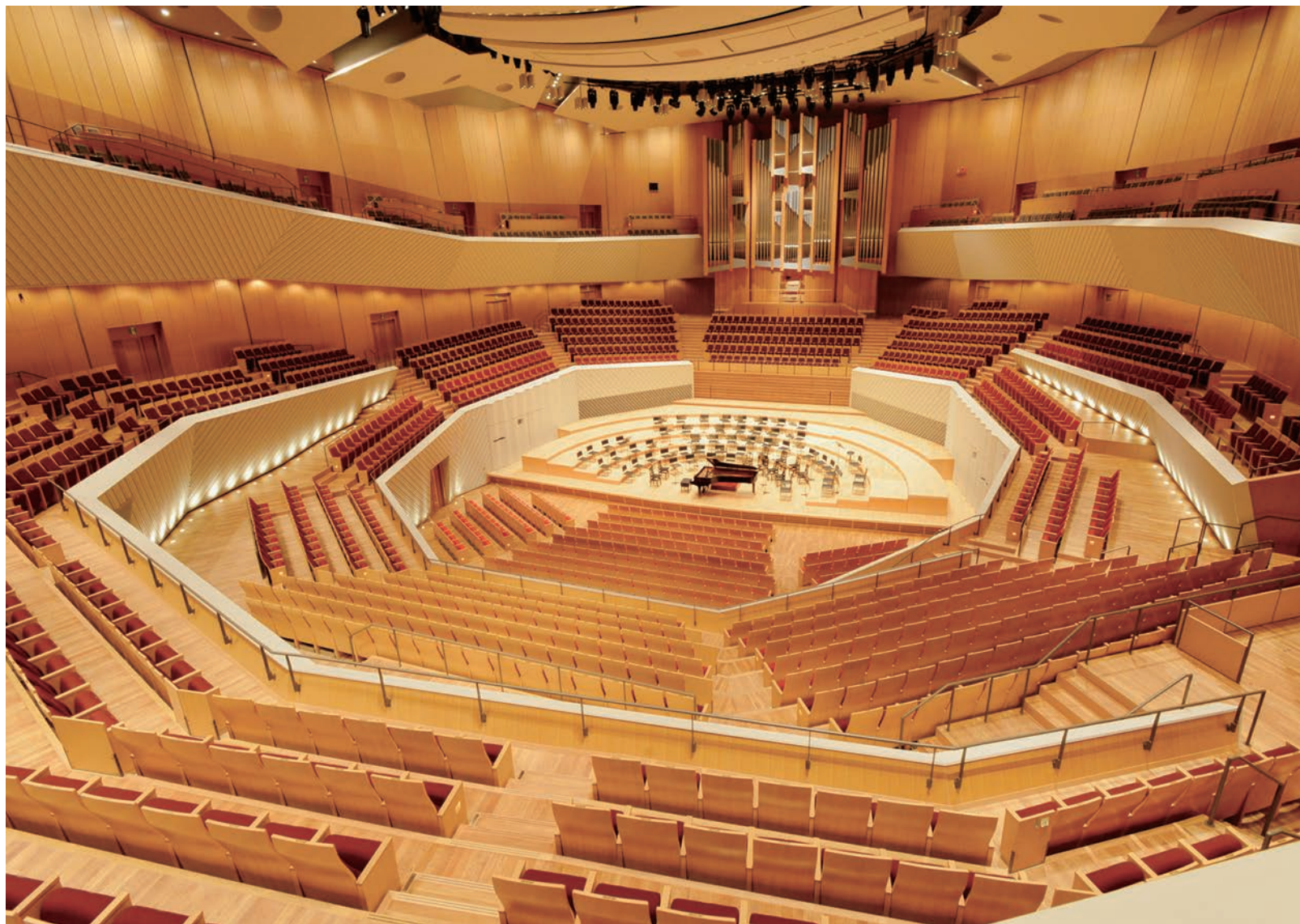
ミュージアム川崎シンフォニーホール ヒノキ集成フローリング（無節）48mm / 100㎡ © 堀田正矩
